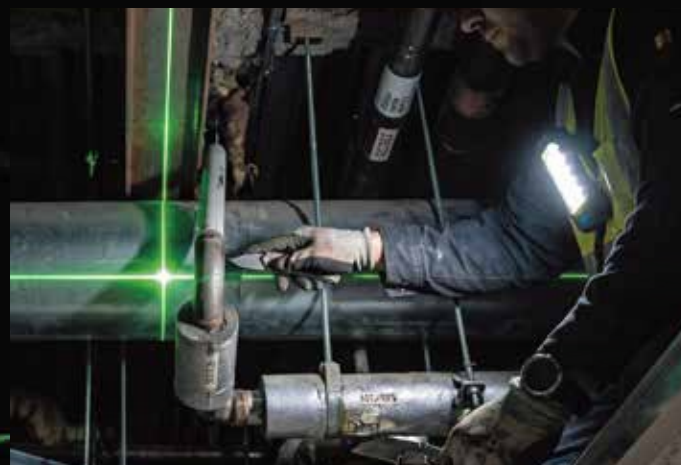
配管スペースなどの狭所
