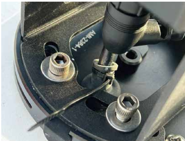
図28: ケーブルタイの取り付け
